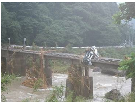
橋の欄干に引っかかった軽トラック
